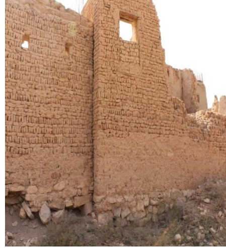
لوحة (١) الواجهة الشمالية لحصن الهنداوي، ويظهر بها تلاصق واجهات الدور
